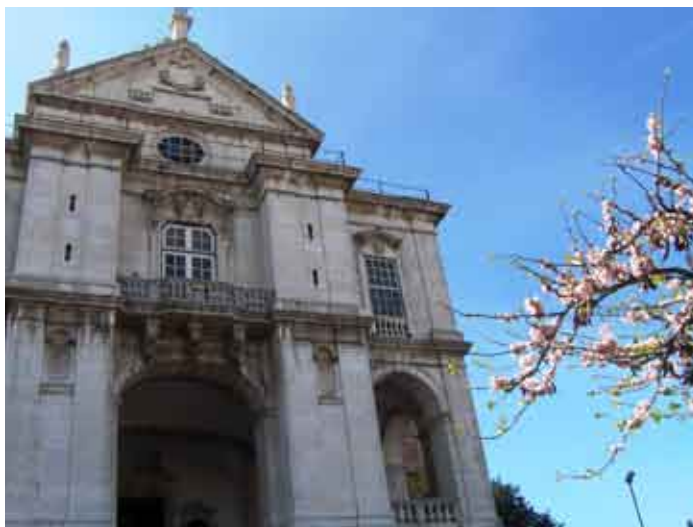
Fig. 9. Fachada da Igreja da Nossa Senhora da Penha de França.
