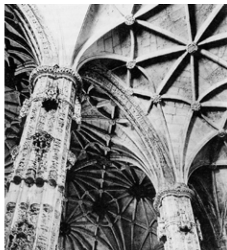
Fig. 18. Interior do Mosteiro de Santa Maria de Belém, ou dos Jerónimos, com a famosa abóbada em dossel do arquitecto João de Castilho.
